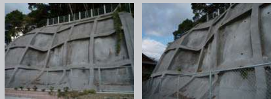
長崎県・法面施工 使用商品:バイフェロックス黒
