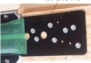
ダンパー本体、延長木材A・Bが、可能な限り直線ならびに水平になるよう確認し、 step3 で仮留めしたビスも含め、片面で合計7本、ショートビスで留めてください。
