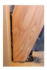
■取付の際、金槌等で押し込むとダンパーが縮み入りますが、極端なたたき込みはしないでください。ダンパーのニュートラルの位置が狂う恐れがあります。
