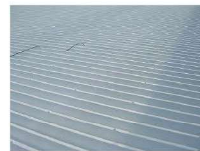
K社・工場(折板屋根)
