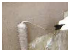
ハウスシューズ102・202 ラビットシューズEM (標準砂骨ローラーで施工)
