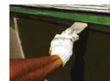
トップコート (ハケで施工)
