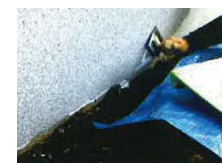
トップコート多彩色 (プラコテ、標準砂骨ローラーで施工)
