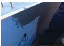
カチオンミラクル(全面補修) ※1日養生
