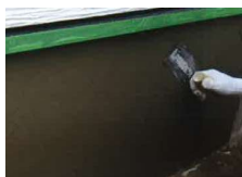
リフェイス ピンホールのない平滑な下地作成
