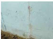
メッシュテープ伏せ込み(ジョイント部)
