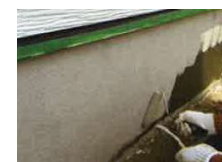
トップコート (ウールローラーで施工)
